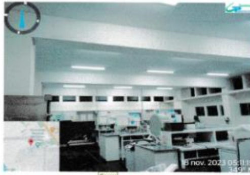
INSTALACION DE EQUIPOS FLUORESCENTES Y PINTADO DE TECHO
