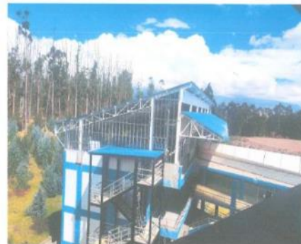
FOTOGRAFÍA N° 9: Se observa la estructura para fibrocemento en lado lateral del bloque G y H.
