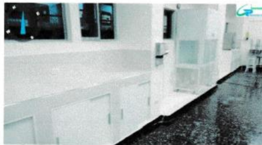
MUEBLERIA DE MELAMINE, PINTURA Y LIMPIEZA FINAL DE OBRA
