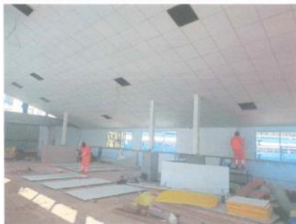
FOTOGRAFÍA N° 4: Se verificaron los trabajos de pintado de muros interiores en zona de Bloque G y H.
