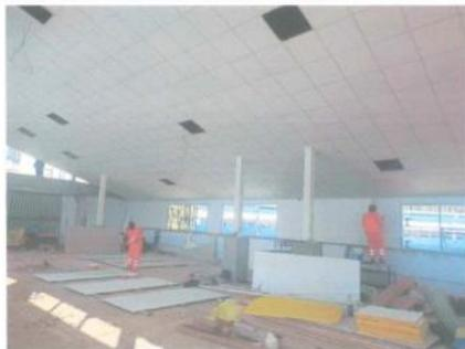
FOTOGRAFÍA N° 9: Se observa la estructura para fibrocemento en lado lateral del bloque G y H.
