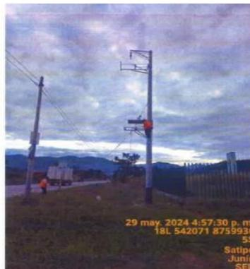
MONTAJE DE LA PORTAESCALERA EN LA ESTRUCTURA DEL PMI
